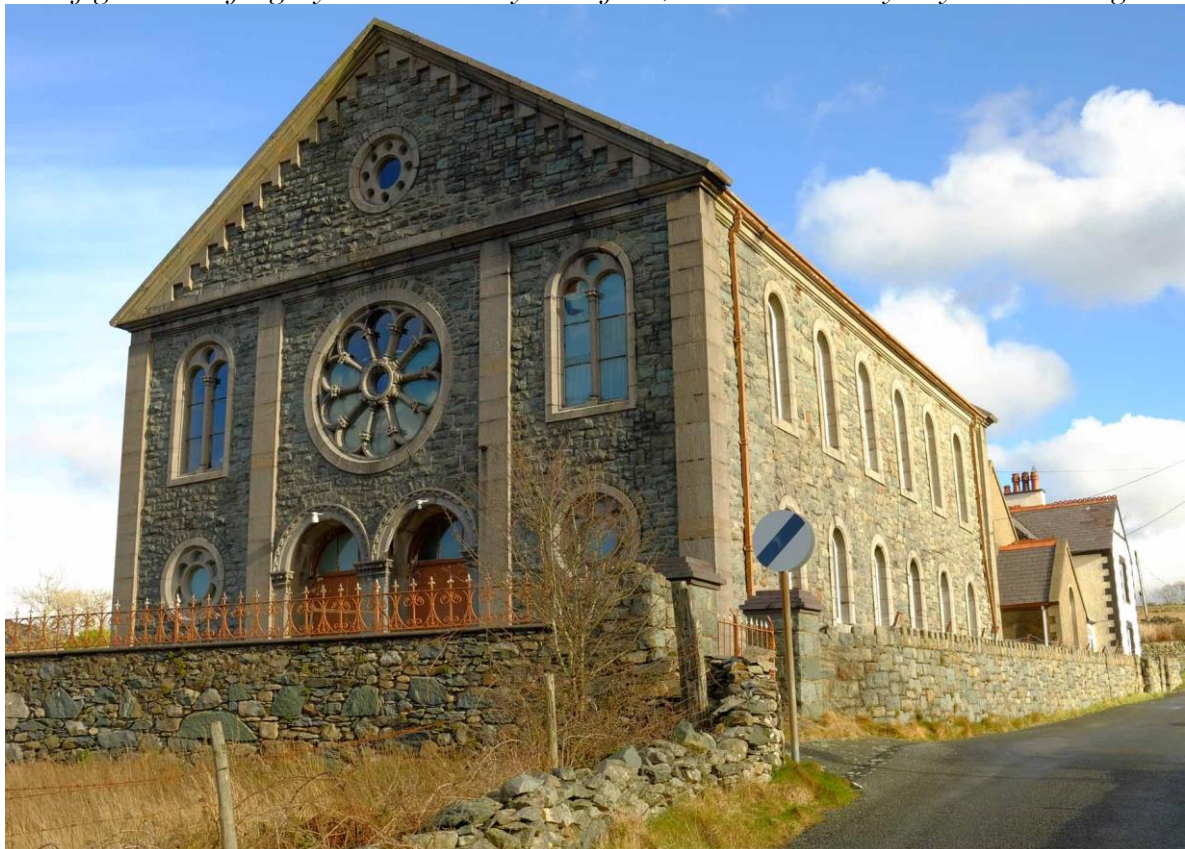
Ffigurwr 14 Capel Cefn y Waun, 1868. Adeiladwyd ei flaen talcennog o gerrig gorchudd, llanrw, gyda cherrig rhywiog wedi'u trin.
