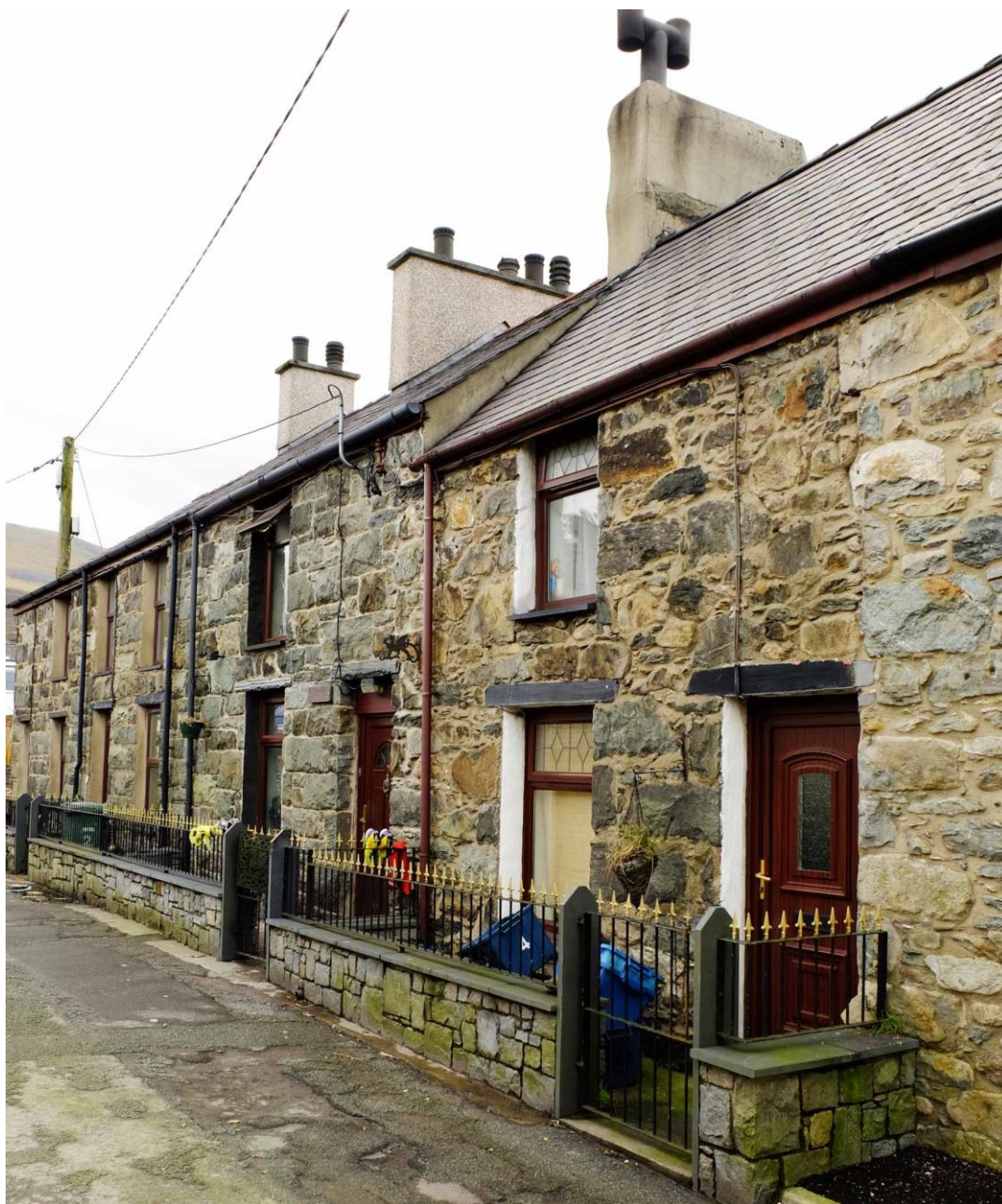
Ffigwr 18 Tai yn Stryd y Tabernacl Adeiladwyd y tŷ ar y dde o gerrig rwbel damweiniol, mae'r tai diweddarach ymhellach i'r chwith wedi'u hadeiladu o gerrig wedi'u cloddio a'u llunio'n fras i flociau. Mae pob adwy o dan gapan drws o glwt o lechen. Mae waliau'r gerddi o gerrig llanw'n fwy diweddar. Yn wreiddiol, agorai'r tai yn syth ar y stryd.
