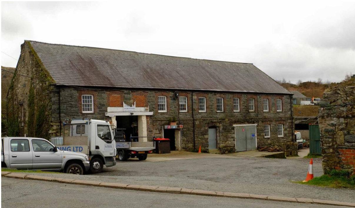
Ffigwr 39 Melin llechi ysgrifennu Glandinorwig, adeilad rhestredig gradd II* a elwir bellach, Melin Sarn. Ar y llawr uchaf, mae'r wyneb o garreg gorchuddio, oddi tano ceir rŵbel damweiniol y llawr is.
