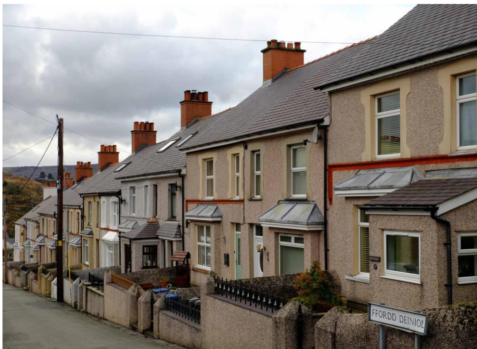
Ffigwr 11 Ffordd Deiniol, a adeiladwyd yn negawd olaf y bedwaredd ganrif ar bymtheg. Mae'r muriau wedi'u chwipio ac mae ganddynt architrafau, ffenestri bwa a simneiau o friciau, sydd oll yn eu neilltuo oddi wrth dai cynharach.
